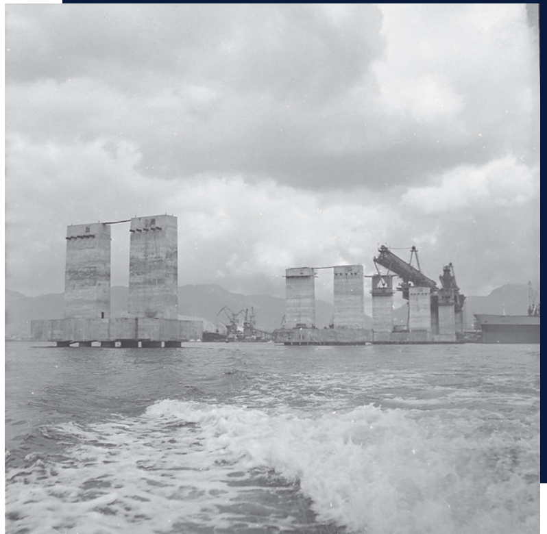
Construção da Ponte Rio-Niterói, 1971.
